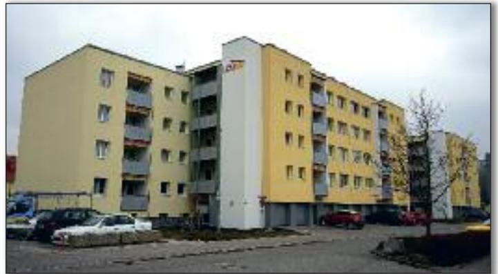
Ein komplett neues „Gesicht“ hat die Wohnhausanlage in der Josef-Haydn-Gasse bekommen: In jedem Stiegenhaus wurde ein Lift eingebaut, neue Garagentore und neue Fenster gehörten ebenso zur Sanierung wie eine neue, wärmegeämmte Fassade. Zuletzt wurden noch die Grünanlagen frühlingsfit gemacht.
